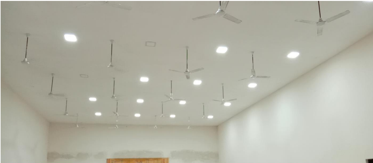
Unnamed Road, Darri, Chhattisgarh 491661, India Latitude 20.952788° Longitude 80.850061° LOCAL 04:03 PM GMT 10:33 AM TUESDAY 24.08.2021 ALTITUDE 67 METER
